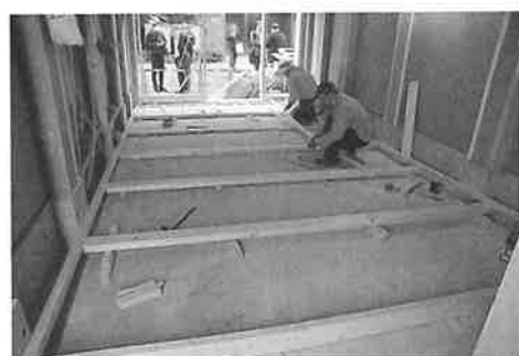
見学時は床組み工事中（1階）
