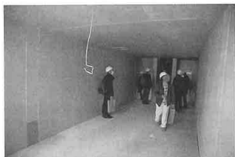
耐火被覆された室内（3階）
