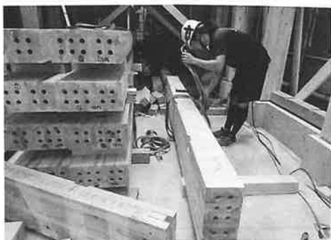
梁材の揚重作業
